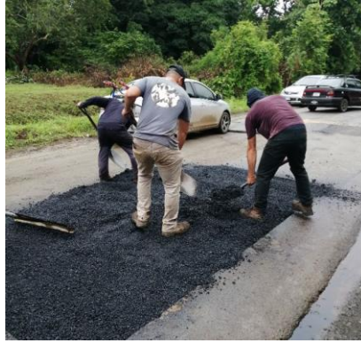
Fotografías 32. Colocación de bacheo Fuente: Informe labores.
