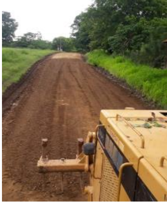
Fotografías 21. Mejora de superficie de ruedo. Fuente: Informe labores.
