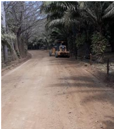
Fotografías 13. Mejora de superficie de ruedo. Fuente: Informe labores.
