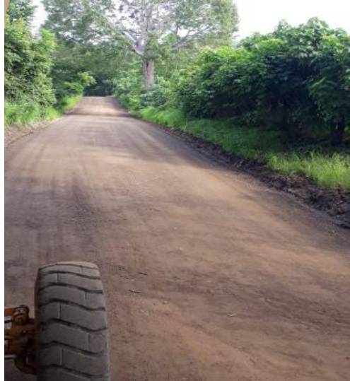
Fotografías 19. Mejora de superficie de ruedo. Fuente: Informe labores.
