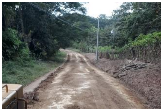
Fotografías 27. Mejora de superficie de ruedo. Fuente: Informe labores.
