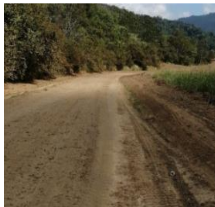
Fotografías 17. Mejora de superficie de ruedo. Fuente: Informe labores.
