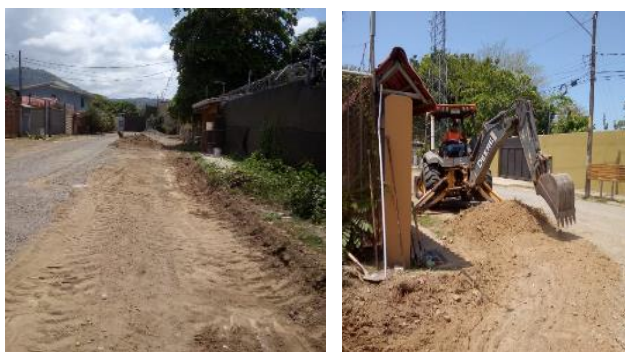
Fotografías 6. Mejora de superficie de ruedo. Fuente: Informe labores.
