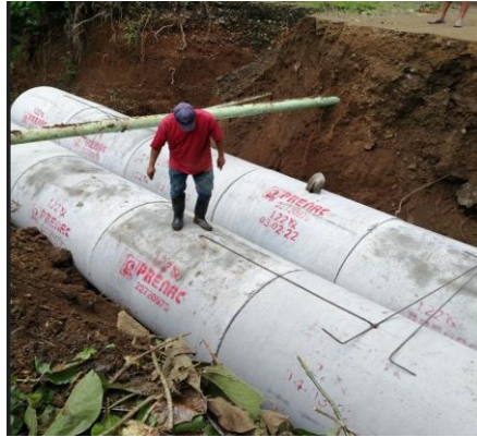
Fotografías 24. Colocación de alcantarilla. Fuente: Informe labores.
