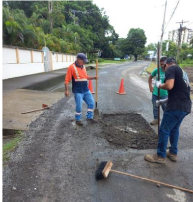
Fotografías 28. Preparación para asfaltado. Fuente: Informe labores.
