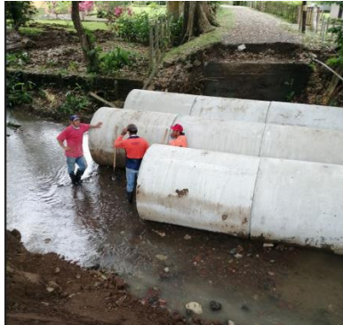
Fotografías 34. Colocación de alcantarilla. Fuente: Informe labores.
