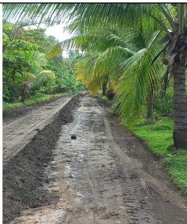
Fotografías 47. Mejora de superficie de ruedo. Fuente: Informe labores.
