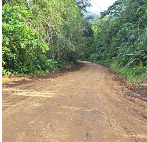
Fotografías 43. Mejora de superficie de ruedo. Fuente: Informe labores.
