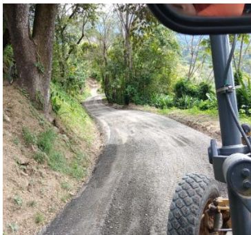
Fotografías 4. Mejora de superficie de ruedo. Fuente: Informe labores.
