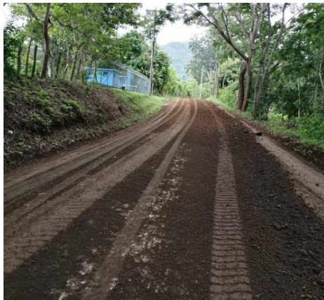
Fotografías 51. Mejora de superficie de ruedo. Fuente: Informe labores.
