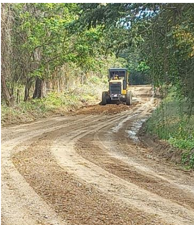
Fotografías 48. Mejora de superficie de ruedo. Fuente: Informe labores.
