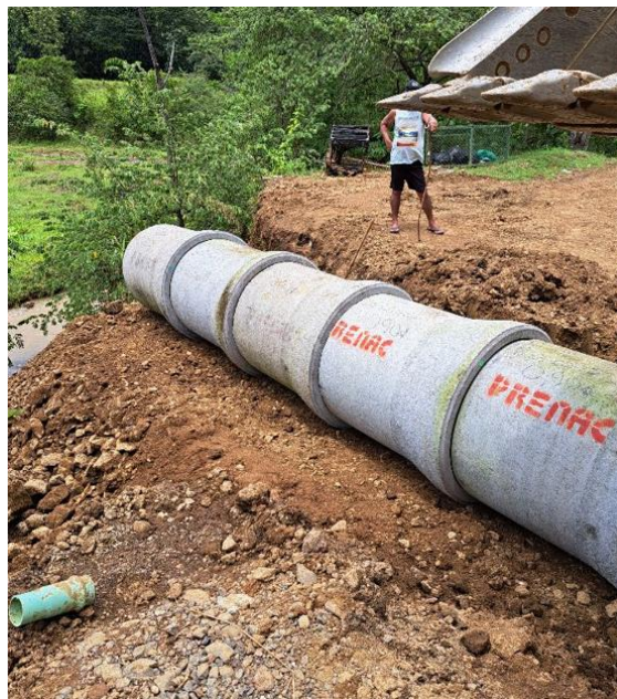
Fotografías 38. Colocación de alcantarilla. Fuente: Informe labores.
