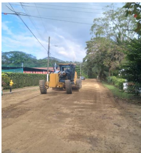
Fotografías 42. Mejora de superficie de ruedo. Fuente: Informe labores.
