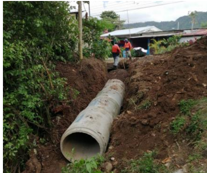
Fotografías 33. Colocación de alcantarilla. Fuente: Informe labores.
