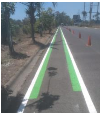
Fotografías 11. Mejora de superficie de ruedo. Fuente: Informe labores.
