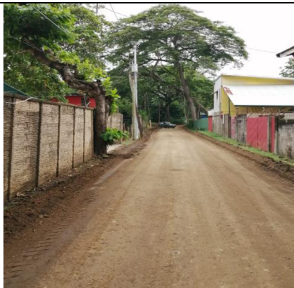
Fotografías 41. Mejora de superficie de ruedo. Fuente: Informe labores.
