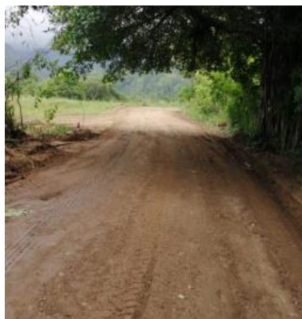
Fotografías 18. Mejora de superficie de ruedo. Fuente: Informe labores.
