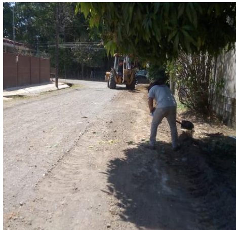
Fotografías 7. Mejora de superficie de ruedo. Fuente: Informe labores.
