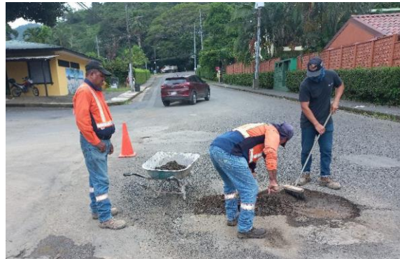
Fotografías 29. Preparación para asfaltado Fuente: Informe labores.
