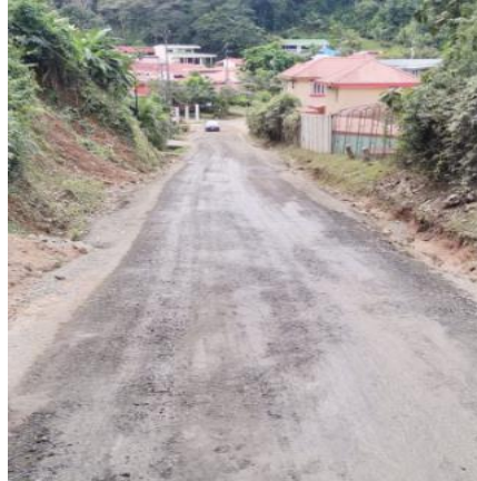
Fotografías 12. Mejora de superficie de ruedo. Fuente: Informe labores.
