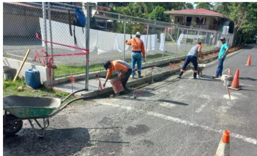
Fotografías 54. Construcción de aceras. Fuente: Informe labores.
