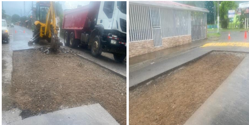
Fotografías 22. Mejora de superficie de ruedo. Fuente: Informe labores.
