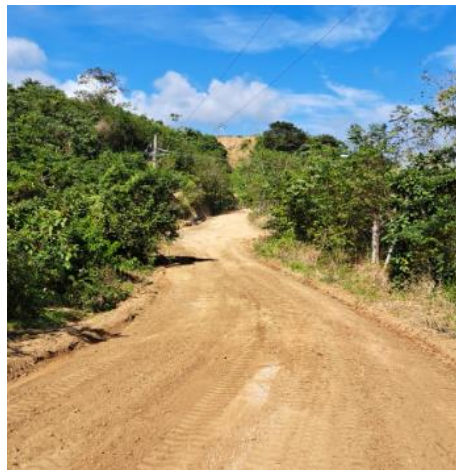
Fotografías 50. Mejora de superficie de ruedo. Fuente: Informe labores.
