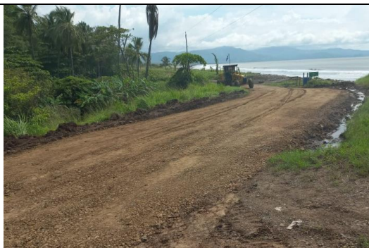
Fotografías 45. Mejora de superficie de ruedo. Fuente: Informe labores.
