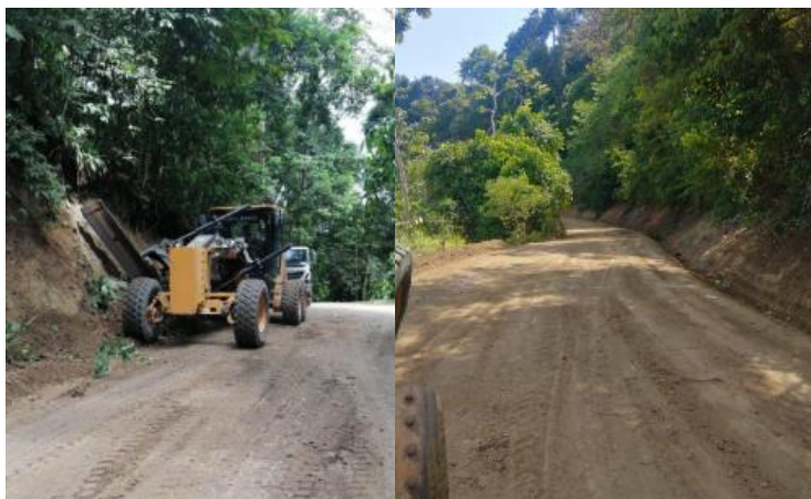
Fotografías 8. Mejora de superficie de ruedo. Fuente: Informe labores.
