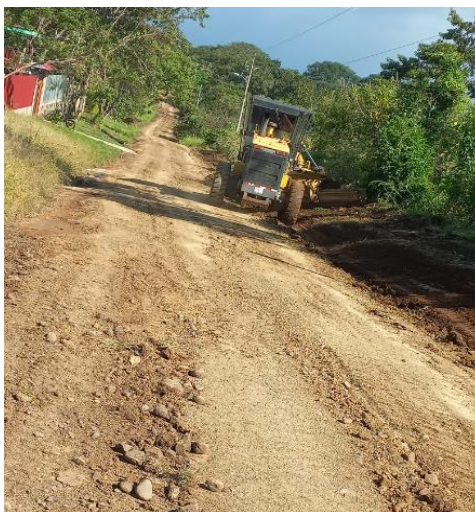
Fotografías 46. Mejora de superficie de ruedo. Fuente: Informe labores.
