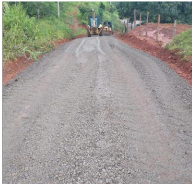
Fotografías 31. Mejora de superficie de ruedo. Fuente: Informe labores.
