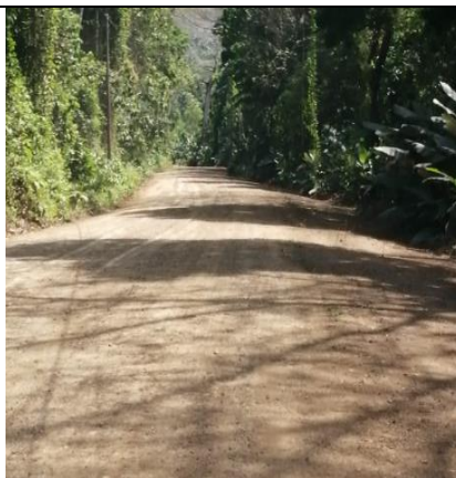
Fotografías 2. Mejora de superficie de ruedo. Fuente: Informe labores.
