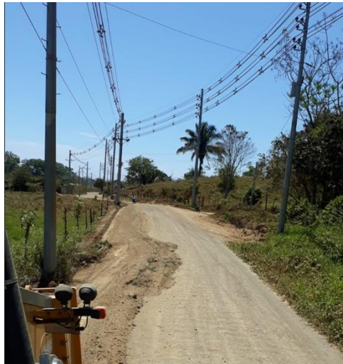
Fotografías 23. Mejora de superficie de ruedo. Fuente: Informe labores.
