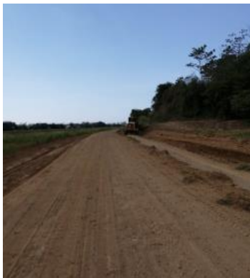
Fotografías 5. Mejora de superficie de ruedo. Fuente: Informe labores.
