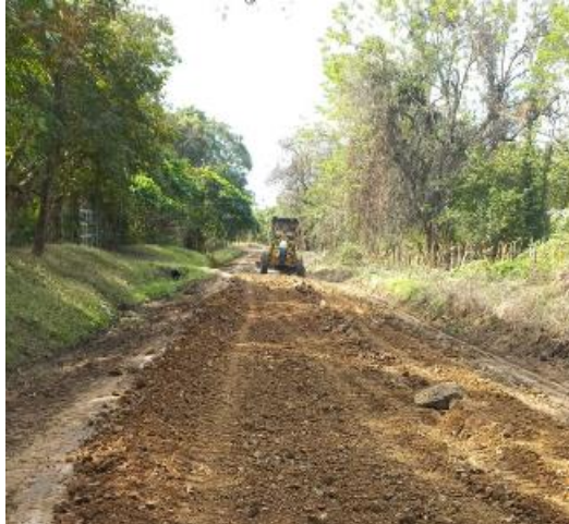
Fotografías 49. Mejora de superficie de ruedo. Fuente: Informe labores.
