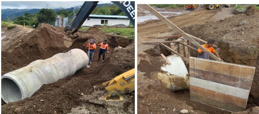
Fotografías 52. Colocación de alcantarilla. Fuente: Informe labores.
