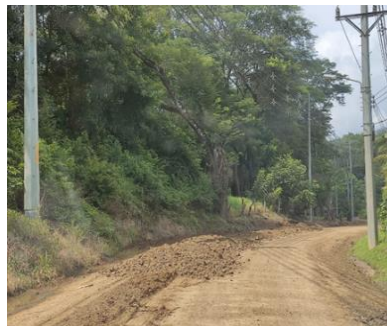
Fotografías 37. Mejora de superficie de ruedo. Fuente: Informe labores.
