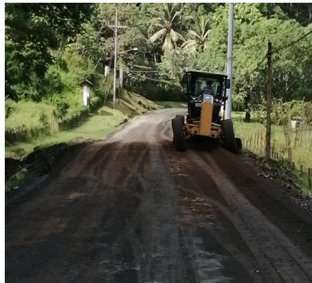
Fotografías 25. Mejora de superficie de ruedo. Fuente: Informe labores.
