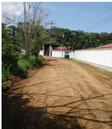
Fotografías 16. Mejora de superficie de ruedo. Fuente: Informe labores.
