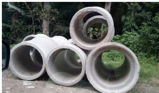
Fotografías 26. Colocación de alcantarilla. Fuente: Informe labores.
