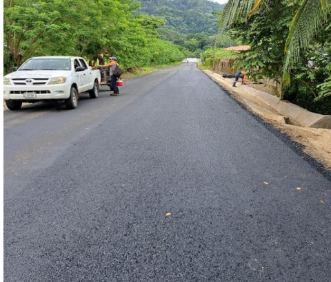
Fotografías 39. Mejora de superficie de ruedo. Fuente: Informe labores.
