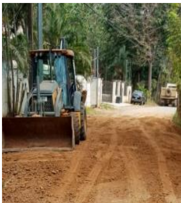
Fotografías 14. Mejora de superficie de ruedo. Fuente: Informe labores.
