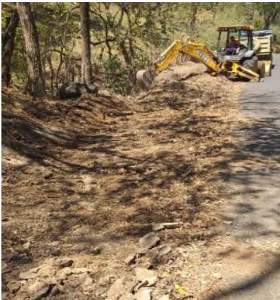
Fotografías 1. Mejora de superficie de ruedo. Fuente: Informe labores.
