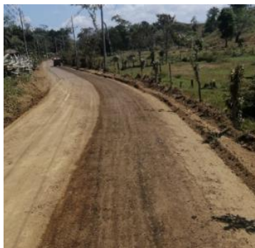
Fotografías 15. Mejora de superficie de ruedo. Fuente: Informe labores.
