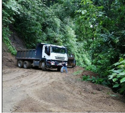
Fotografías 30. Mejora de superficie de ruedo. Fuente: Informe labores.
