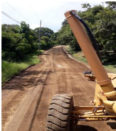
Fotografías 20. Mejora de superficie de ruedo. Fuente: Informe labores.
