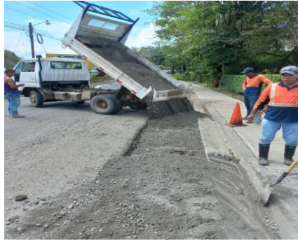
Fotografías 53. Colocación de base mejorada con cemento. Fuente: Informe labores.
