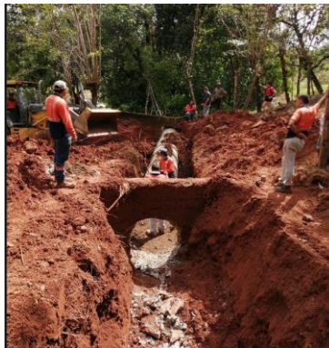
Fotografías 35. Colocación de alcantarilla. Fuente: Informe labores.
