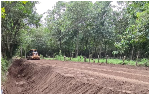
Fotografías 40. Mejora de superficie de ruedo. Fuente: Informe labores.
