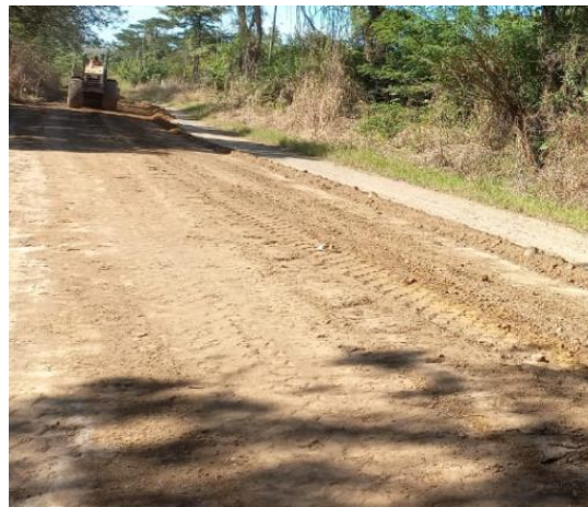
Fotografías 44. Mejora de superficie de ruedo. Fuente: Informe labores.
