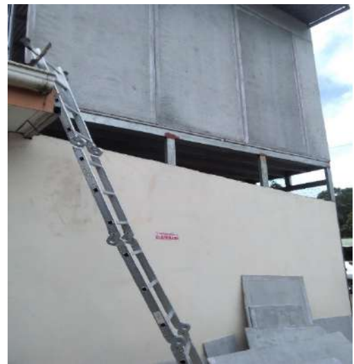
Inspección previa para aprobación de un permiso de construcción
