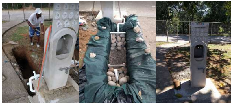
Figura 5 Proceso de construcción de las biojardineras: ejemplo Herradura
